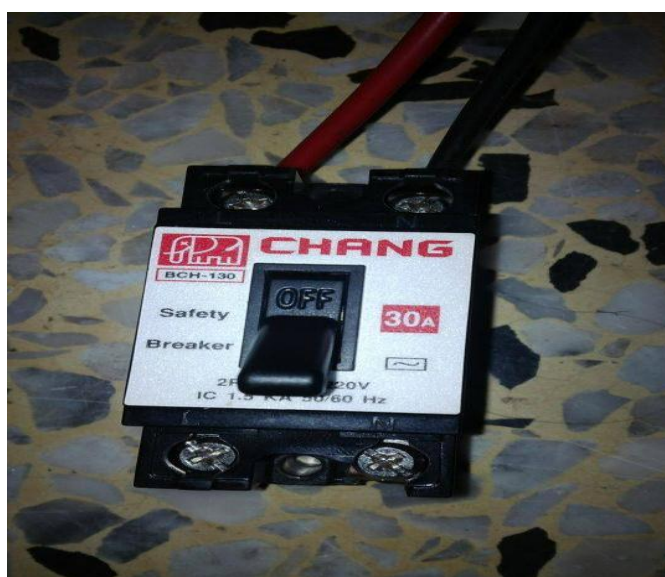
ภาพที่ 3.9 Circuit Breaker ขนาด 30 A ป้องกันกระแสไฟฟ้าเกินพิกัด
