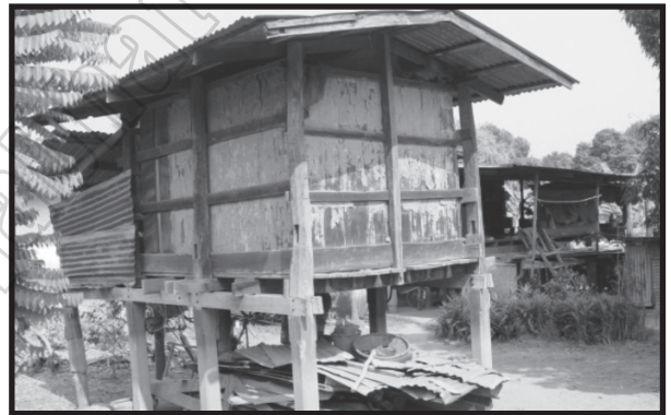
รูปแบบที่ 1. ลักษณะเป็นไม้แผ่นเรียงขึ้นเป็นชั้นๆ (รูปยุ้งข้าว อ.วังสะพุง จ.เลย)
