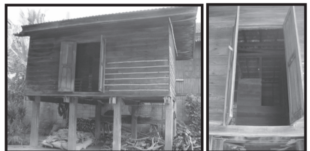
รูปแบบที่ 2. ลักษณะเป็นบานเปิด - ปิด คล้ายประตูหน้าต่างบ้านเรือนปัจจุบัน (รูปยุ้งข้าว อ.ห้างฉัตร จ.ลำปาง)
