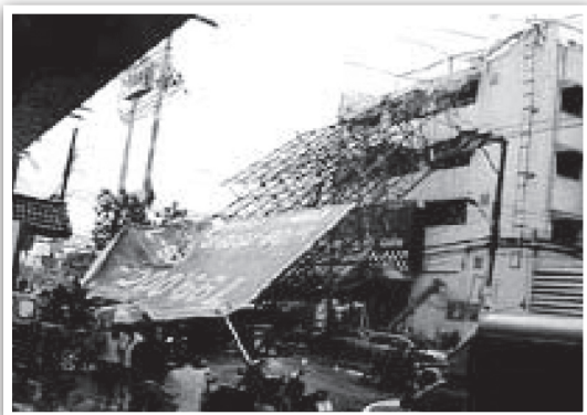
รูปที่ 1 การวิบัติของป้ายโฆษณาเนื่องจากแรงลม (www.bkknew.net และ http://www.udon-city.com)
