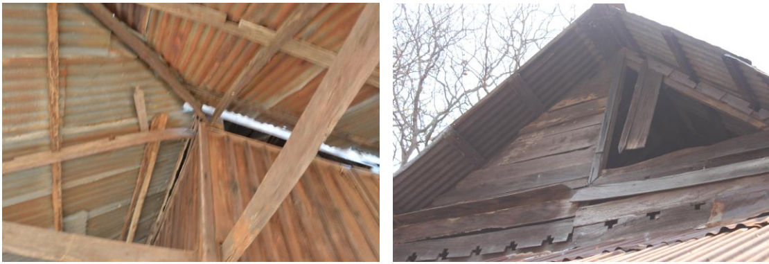
ภาพที่ 4.31 โครงสร้างใต้หลังคา และหน้าบันของสิมวัดสระแก
