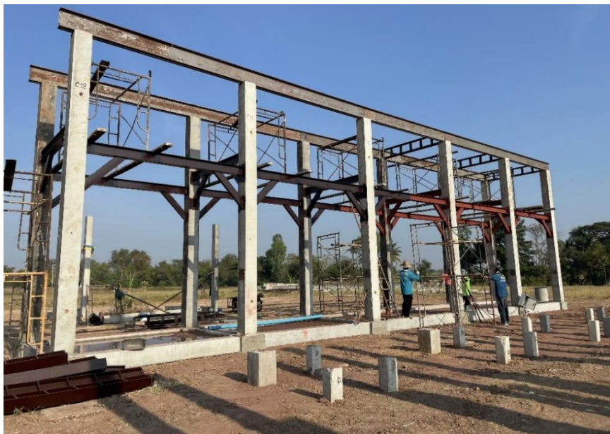
ภาพที่ 4.49 ตรวจสอบคืบหน้าโรงงานน้ำแข็ง วันที่ 24 ธันวาคม 2565
