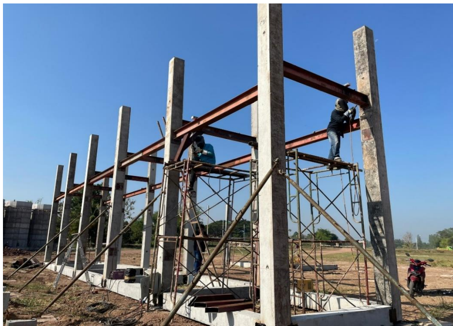
ภาพที่ 4.48 ตรวจสอบความคืบหน้าโรงงานน้ำแข็ง วันที่ 19 ธันวาคม 2565 ที่มา : ผู้วิจัย
