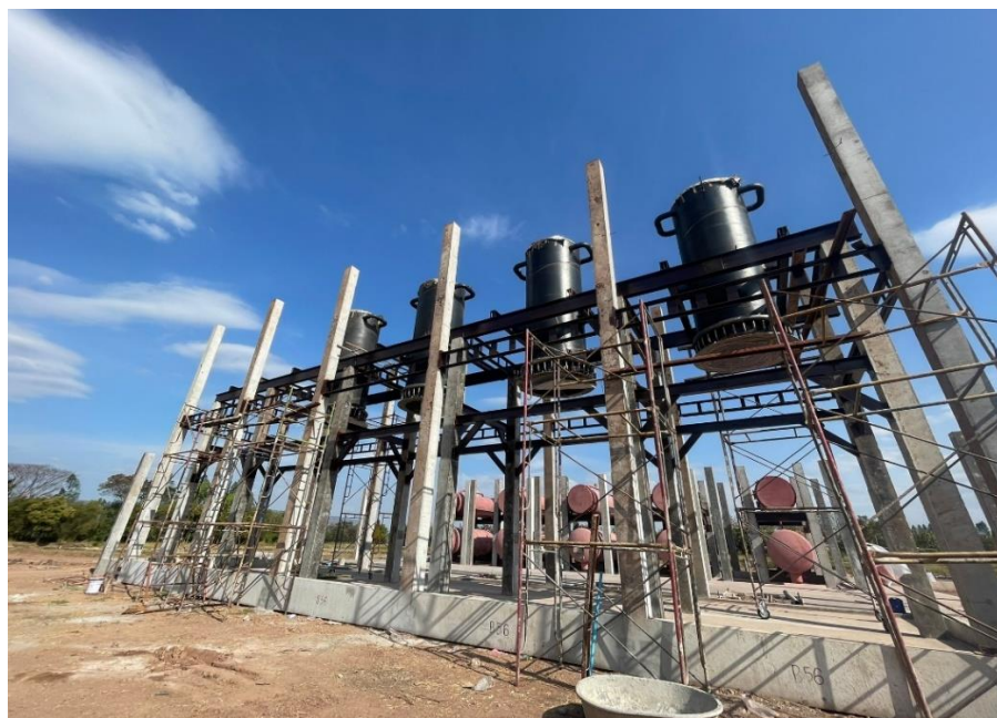
ภาพที่ 4.51 ตรวจสอบความคืบหน้าโรงงานน้ำแข็ง วันที่ 24 มกราคม 2566
