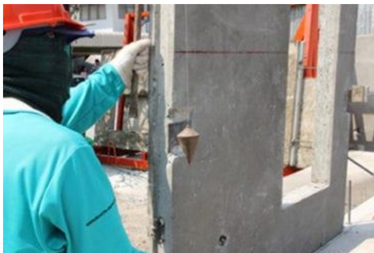
ภาพที่ 2.7 ระบบ PRECAST นวัตกรรมใหม่ของปี 2017
