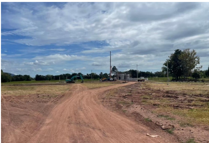
ภาพที่ 4.44 ตรวจสอบความคืบหน้าโรงงานน้ำแข็ง วันที่ 27 ตุลาคม 2565
