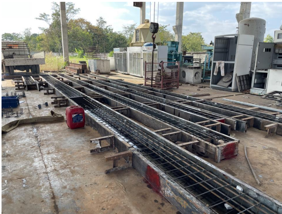
ภาพที่ 4.47 การวางเหล็กแม่แบบสำหรับหล่อคานคสล.ภายในโรงงาน ที่มา : ผู้วิจัย
