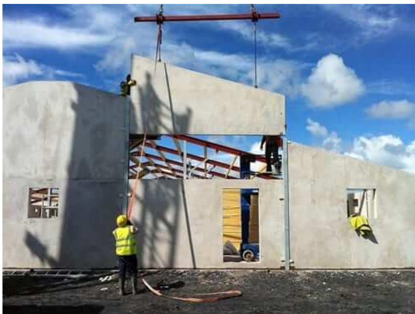
ภาพที่ 2.8 ระบบ PRECAST นวัตกรรมใหม่ของปี 2017
