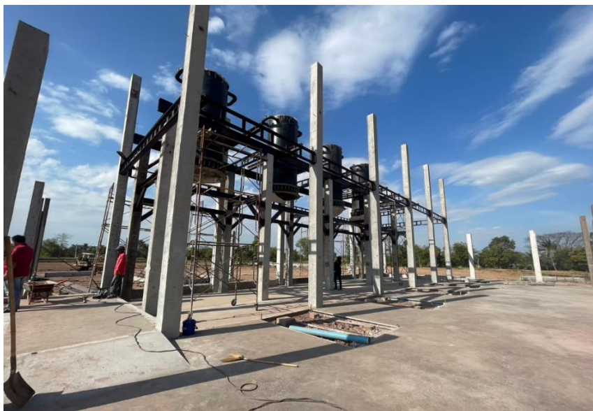
ภาพที่ 4.52 ตรวจสอบความคืบหน้าโรงงานน้ำแข็ง วันที่ 26 มกราคม 2566
