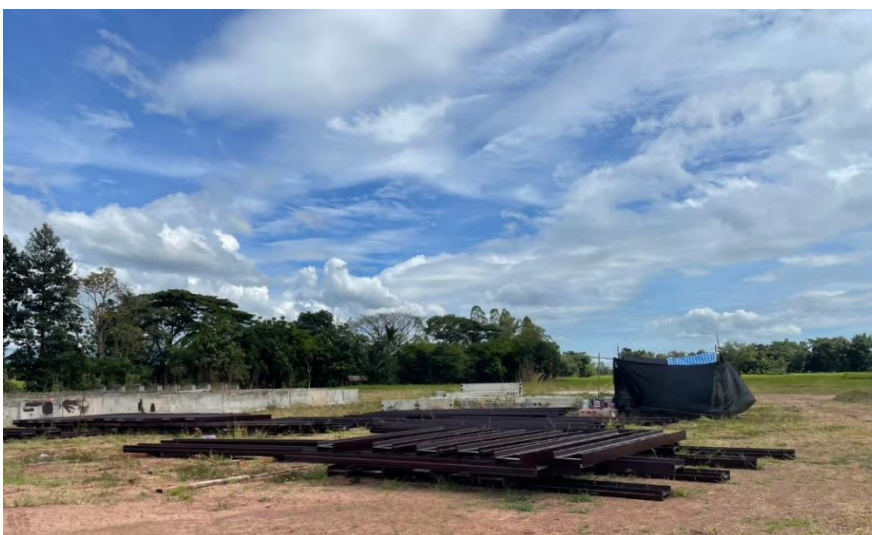
ภาพที่ 4.45 คานเหล็กที่ตัดไว้แล้ว เป็นส่วนของโครงสร้างอาคารที่ได้เตรียมไว้แล้วหน้างาน
