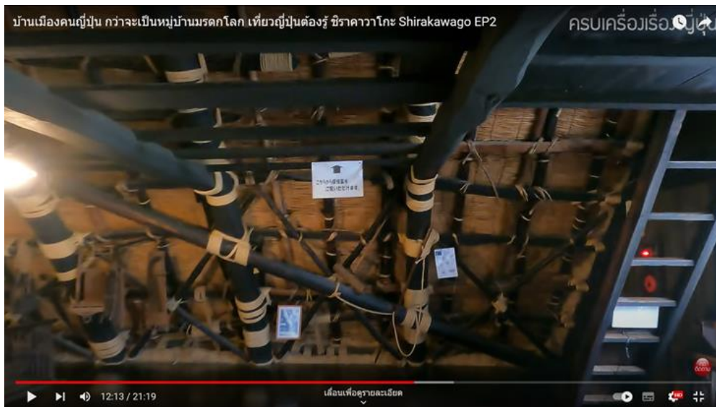
ภาพที่ 3.12 โครงสร้างหลังคา (ภายใน)
