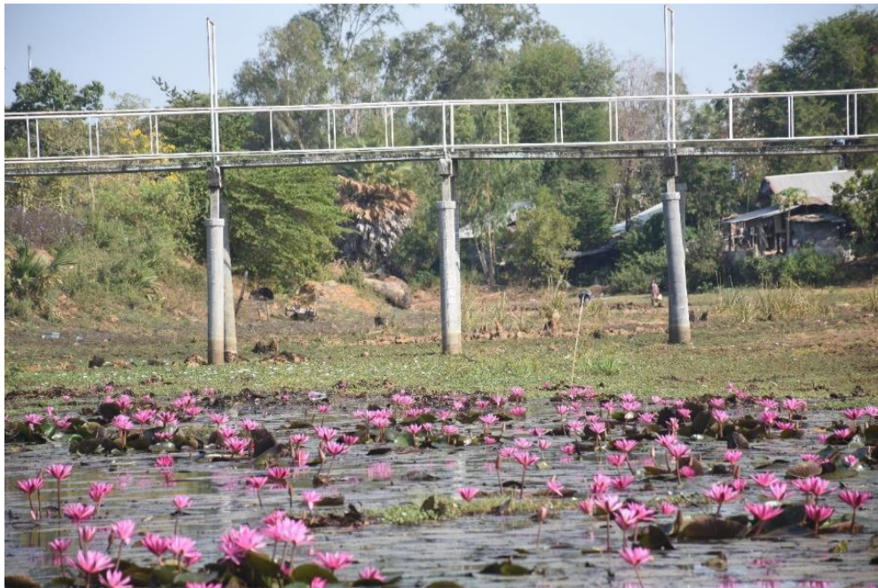
ภาพที่ 4.10 สะพานหลวง
