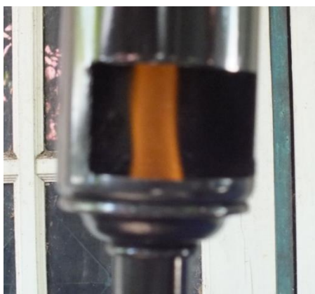
ภาพที่ 3.55 ภาพแสดงการตรวจเช็คแก๊สที่ท่อเช็คแก๊ส
