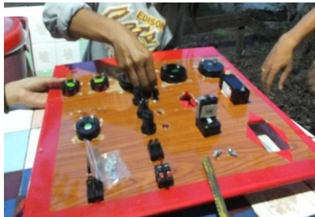
ภาพที่ 3.36 การติดตั้งอุปกรณ์ควบคุมและตรวจวัดระบบไฟฟ้า
