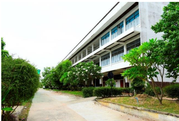
ภาพที่ 2.1 อาคารเรียนโรงเรียนไพศาลพิทยาคม
