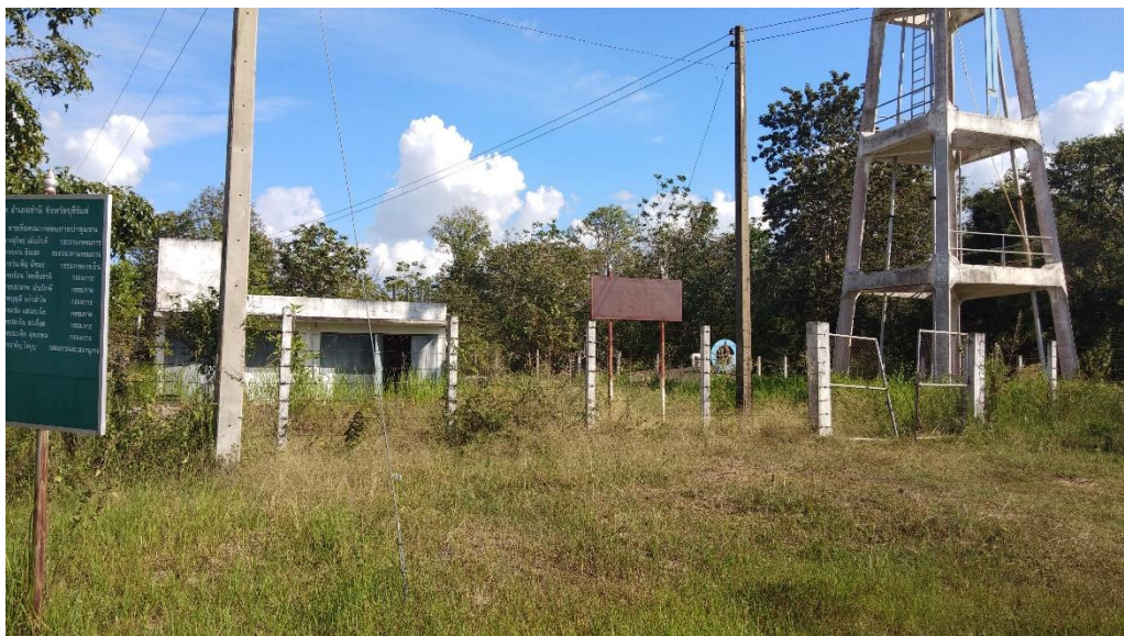
ภาพภาคผนวก ก - 6 สิ่งก่อสร้างในเขต ป่าชุมชนบ้านโคกพะไล ต.ละลาวต อ.ชานี จ.บุรีรัมย์
