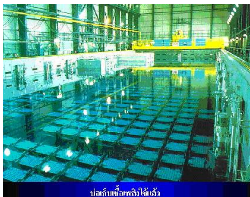
รูปที่ 5 การจัดเก็บกากเชื้อเพลิงที่ใช้แล้ว
