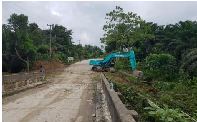
ภาพที่ 5 สถานที่ก่อสร้างจริงของถนน
