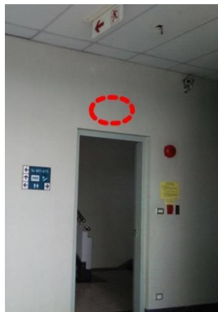
ภาพที่ 7 จุดป้ายบอกทางหนีไฟและตัวอย่างการติดป้าย
