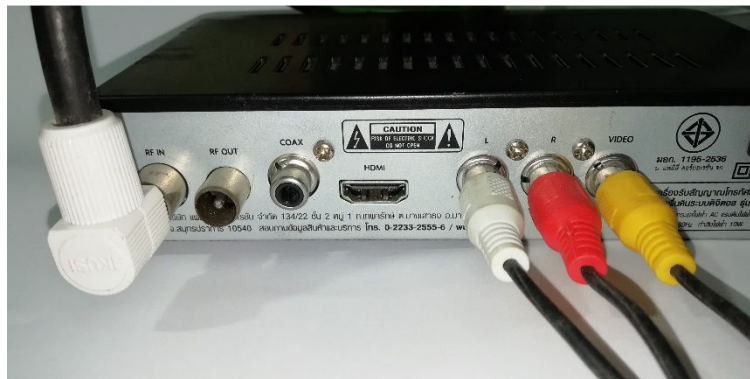
ภาพที่ 3.13 การต่อสัญญาณ AV จาก Set Top Box ไปยังเครื่องรับโทรทัศน์แบบ CRT
