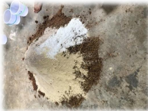
ภาพที่ 35 ใส่นส่วนผสมตามสัดส่วนที่เตรียมไว้
