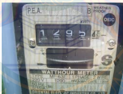
ภาพที่ 3.5 ตัวอย่างตัวเลขของมิเตอร์ที่มีสองแถบสี
