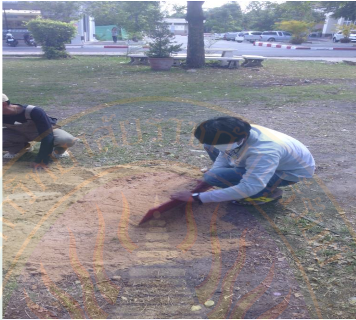
ภาพที่ 36 การเตรียมพื้นที่ให้เรียบโดยการใช้ทราย
