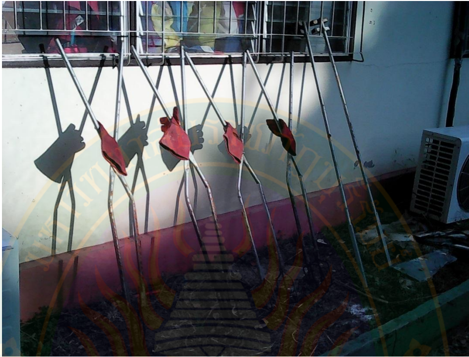
ภาพที่ 56 เตรียมเหล็กคิ๊บขึ้นงาน
