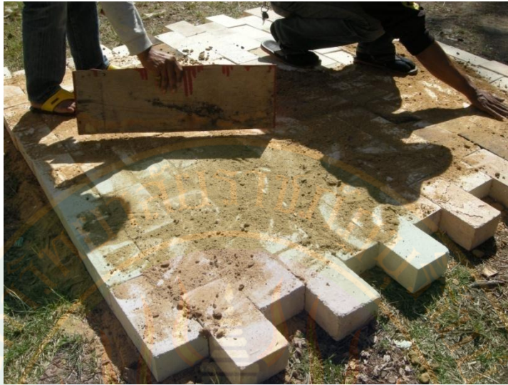
ภาพที่ 38 การจัดวางอิฐทนไฟให้ได้ระนาบเดียวกัน
