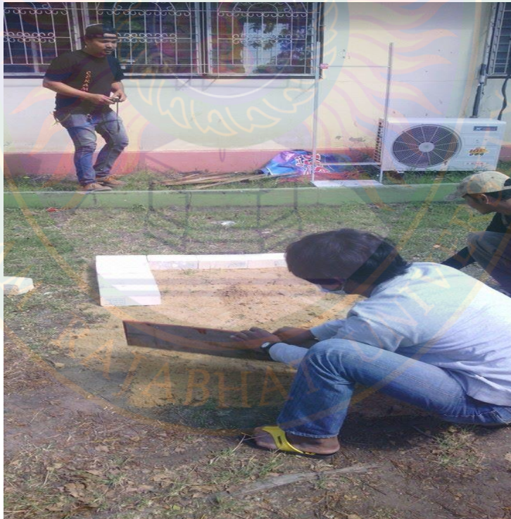
ภาพที่ 37 ทรายรองพื้นเตาช่วยทำให้เก็บความร้อนได้ดี
