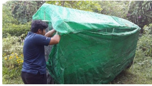
ภาพที่ 28: ทำคลุมสแลนให้ทั่วโรงเรือน
