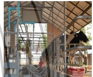
ภาพที่ 11 ท่อส่งลม
