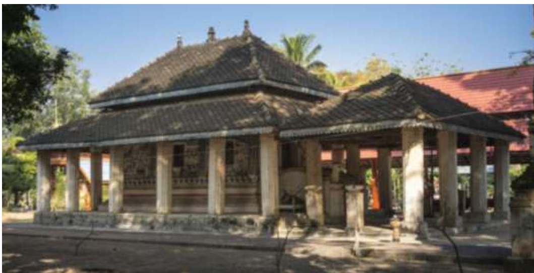
ภาพที่ 4.38 ภาพทัศนียภาพภายนอกของอาคาร
