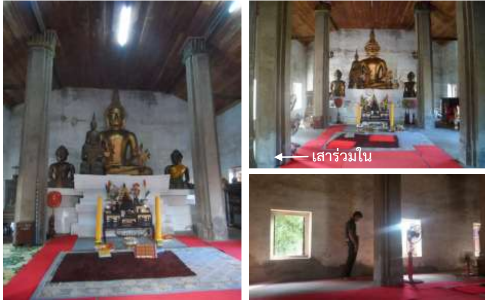
ภาพที่ 4.23 โครงสร้างภายในสิมวัดมณีจันทร์
