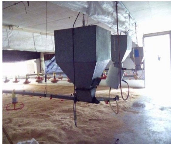
ภาพที่ 3.11 การติดตั้งรางน้ำ รางอาหารภายในโรงเรือน
