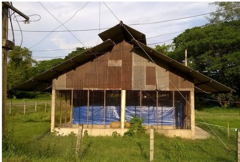
ภาพที่ 3.4 โครงสร้างโรงเรือนสัตว์ปีก หลังคาหน้าจั่ว 2 ชั้น
